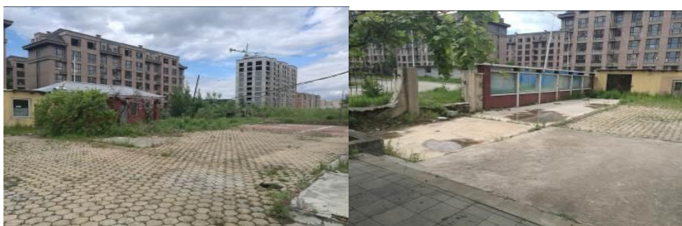
图 2-7 学校北门项目施工前场地图
