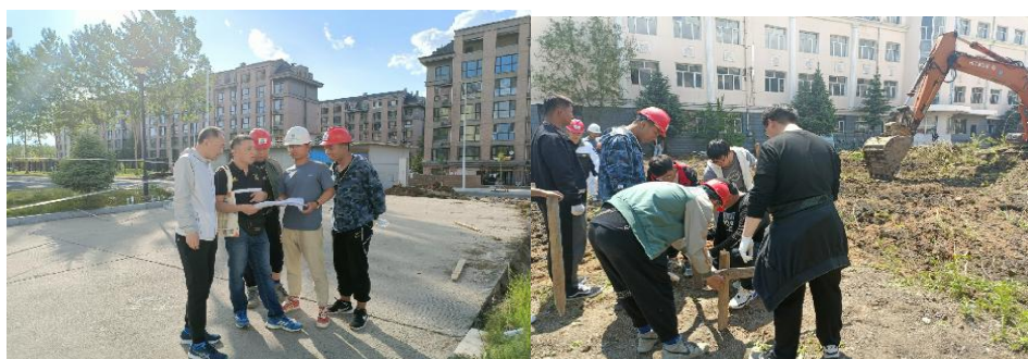
图 2-8 学校北门项目施工现场
