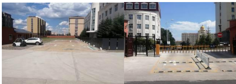
图 2-9 学校北门项目竣工后场地图
